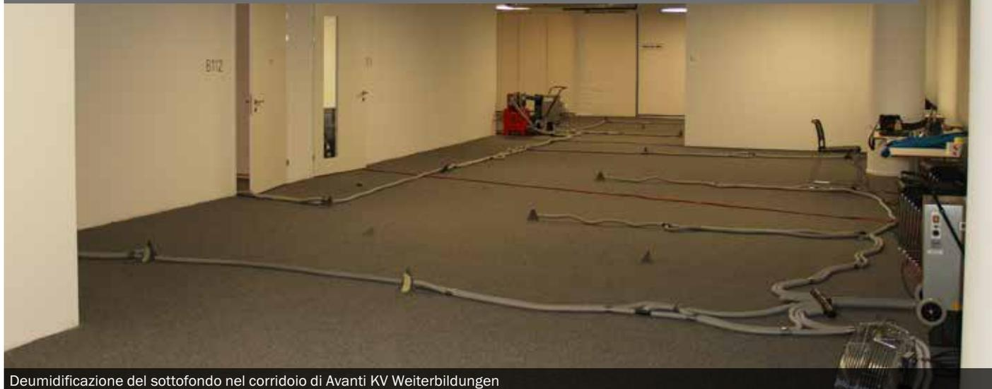
Deumidificazione del sottofondo nel corridoio di Avanti KV Weiterbildungen
